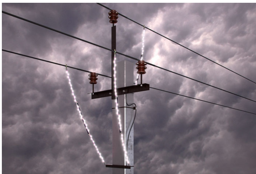
Рисунок 3 - Эскиз срабатывания разрядников
